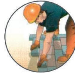
Posa in opera, eseguita manualmente o mezzo macchina, dei masselli autobloccanti secondo schema di posa stabilito
