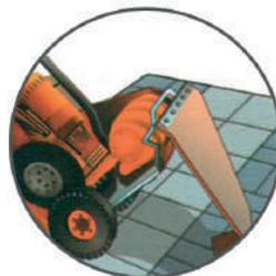
Vibrocompattazione dei masselli autobloccanti con piastra vibrante munita di tappetino in gomma al fine di evitare danneggiamenti alla pavimentazione
