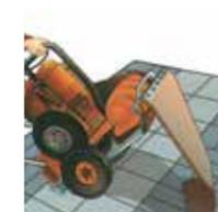
Vibrocompattazione dei masselli autobloccanti con piastra vibrante, munita di tappetino in gomma al fine di evitare rigature, scheggiature o danneggiamenti alla pavimentazione.
