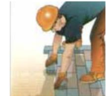
Posa in opera dei masselli autobloccanti che può essere eseguita manualmente o a mezzo di macchine, avente lo scopo di collocare, secondo schema prestabilito i masselli autobloccanti sul piano di allettamento.
