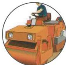
Stesura e compattazione con pietrischetto di allettamento o sabbione per uno spessore di cm 4/5
