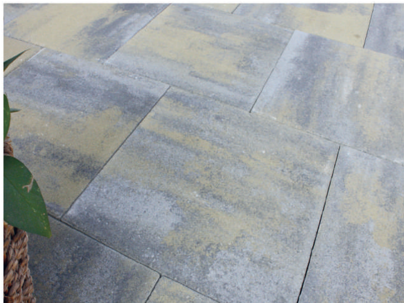
Lastra Mix Luserna posa a giunti alternati
