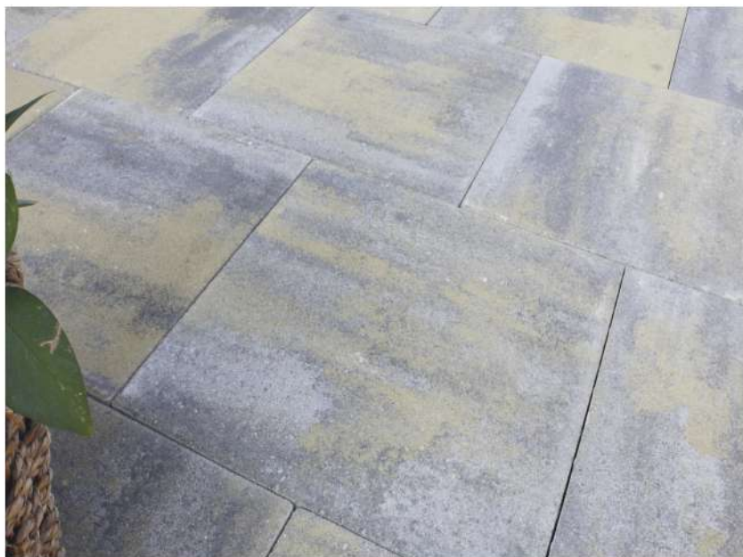
Lastra Mix Luserna posa a giunti alternati
